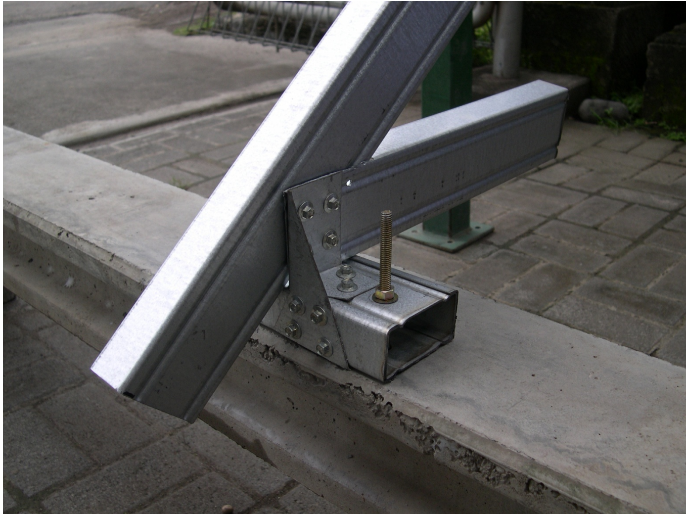
Contoh Sistem Tumpuan Wall-Plate , Kuda-kuda ditumpukan pada Boxed C75.100 , diikat dengan Grip segitiga
